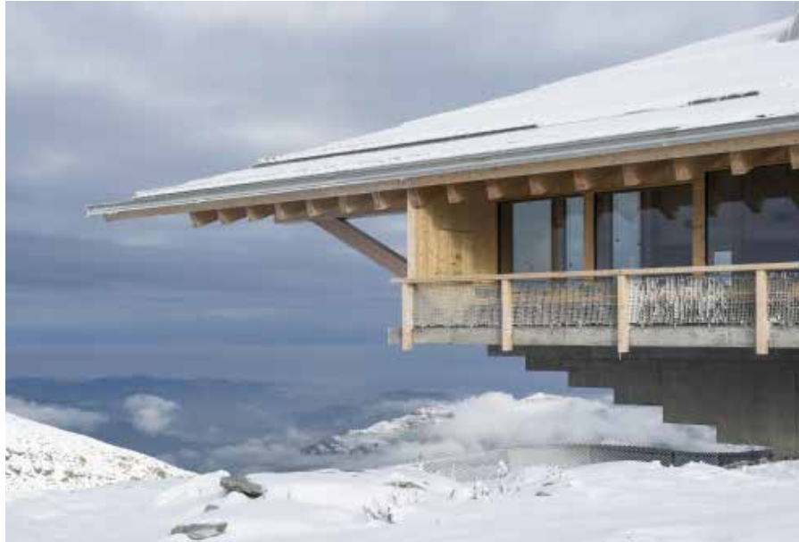
Hoch auf dem östlichsten der sieben Churfürsten breitet die Bergstation mit Restaurant ihr Dach aus.
